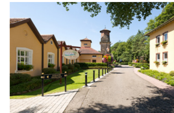
DIE ALTE WEBEREI IN MITTELSTADT
